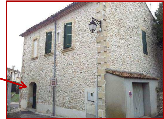
Pièce avec entrée indépendante Actuellement pièce de travail
