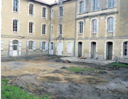
La cour est en travaux. /Photo DDM.
