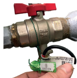
Étiquettes des sondes lisibles, accessibles et proches de la vanne
